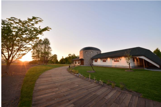
Ferme Laterre 全景
